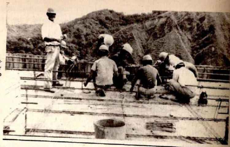
Obreros fundiendo la plancha de un edificio de apartamentos. (Foto Fernando Chavez).
