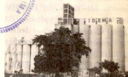
Instalaciones del almacenamiento del Idema. (Foto : Alberto Parra ).
